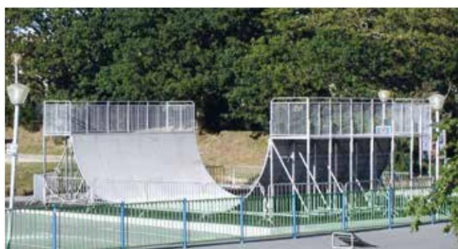
Module unique sur lequel les pratiquants réalisent les mêmes types de figures qu'en Street en passant d'un module à l'autre. Une rampe est un module se composant de 2 courbes opposées reliées par une surface de roulement horizontale. Elle est équipée d'une plate-forme à chacune de ses extrémités.
