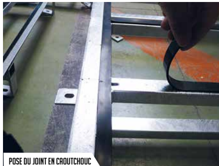
POSE DU JOINT EN CAOUTCHOUC
