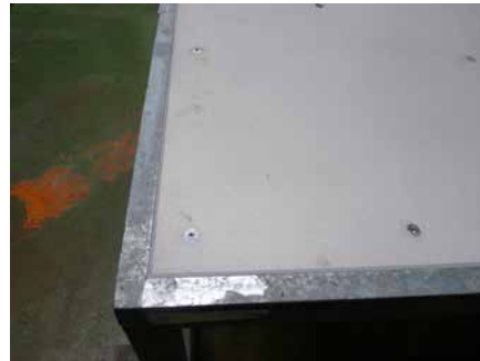
MISE EN PLACE ET FIXATION DE LA SURFACE DE ROULEMENT
